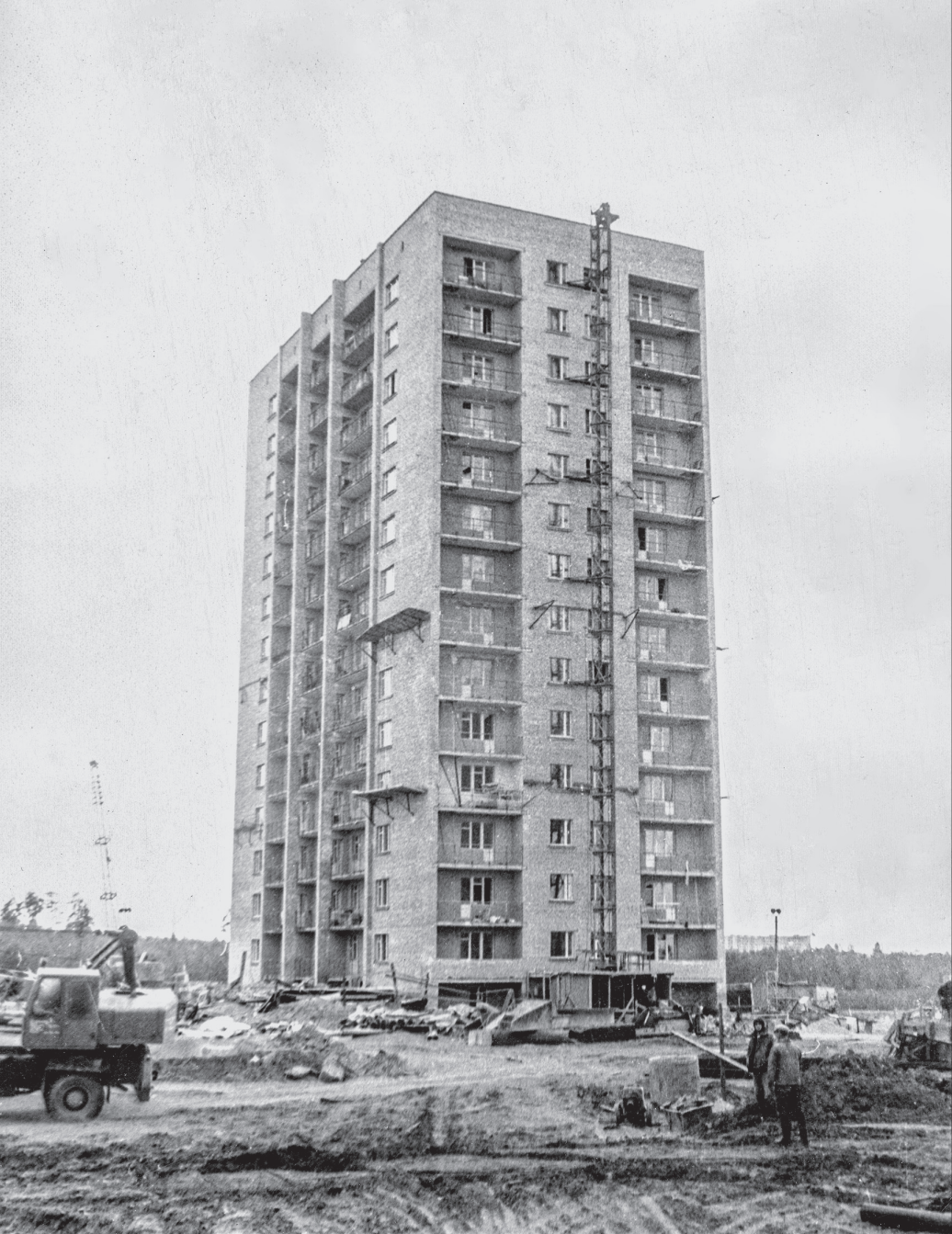
Строительство первого 14-этажного дома в квартале 22 на Черной Речке
