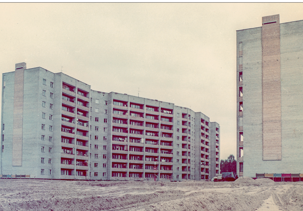
Строительство домов 18, 20 по ул. Понтекорво. 1985 г.
