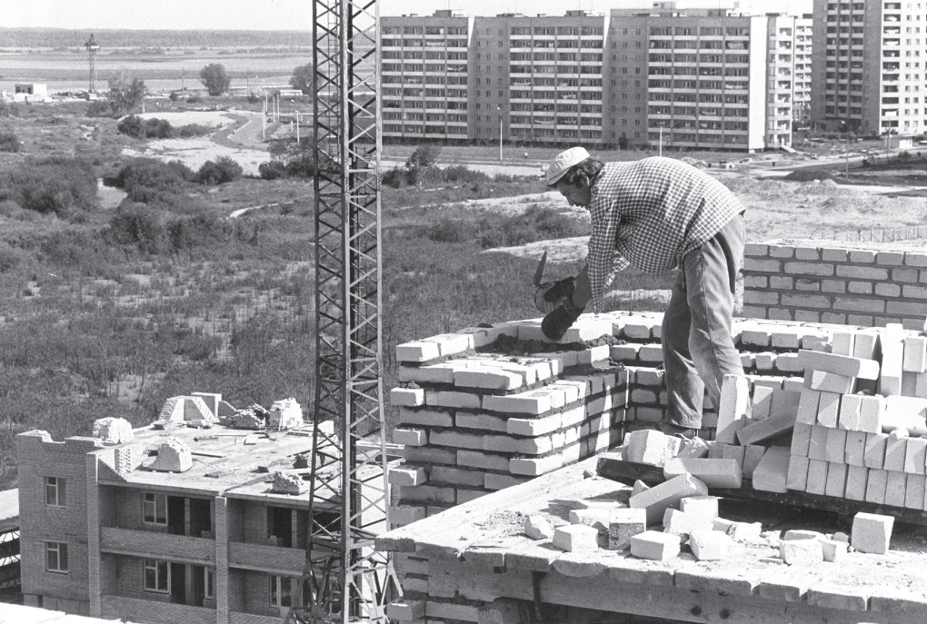
Каменщик А. С. Зятев на строительстве 9-этажного жилого дома в квартале 23
