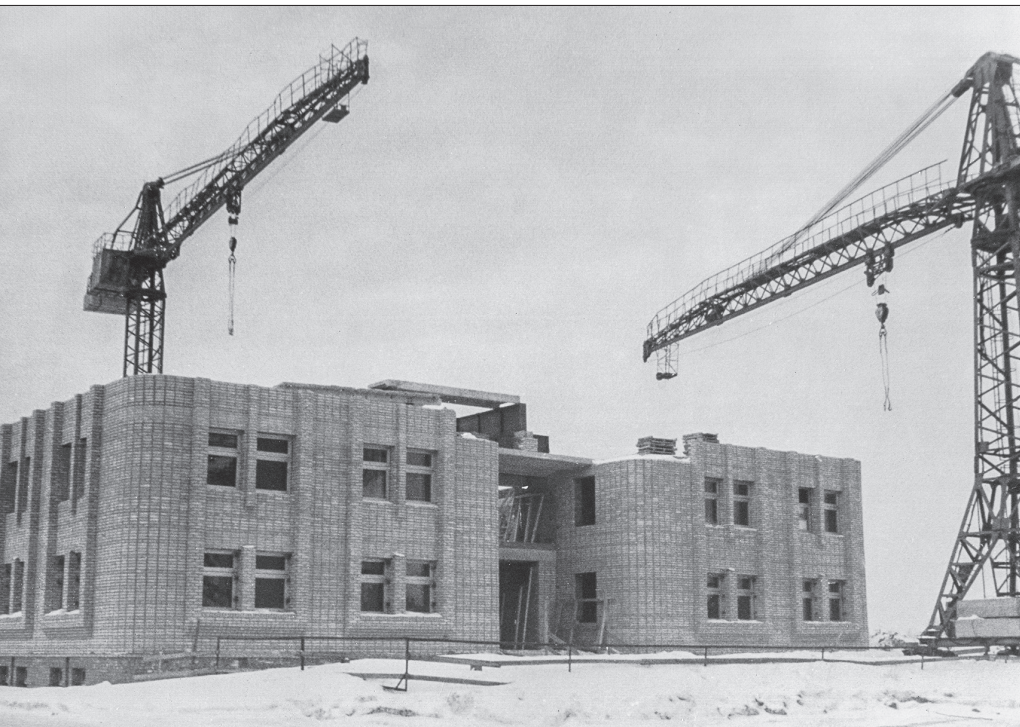
Строительство здания «Госбанка» (пр-т Боголюбова, д. 28). 1980-е годы
