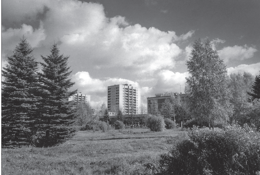
Первые в Дубне 14-этажные дома по ул. Векслера. 1974 г.
