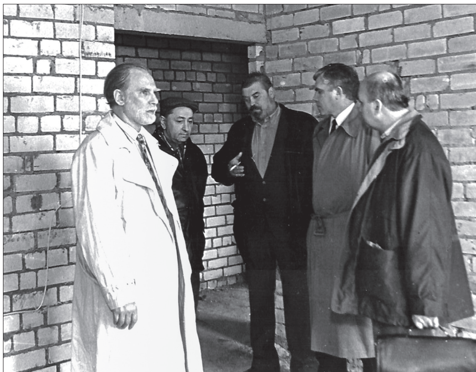
На строительстве жилого дома для работников ОИЯИ. Слева направо: директор ОИЯИ В. Г. Кадышевский, вице-директор ОИЯИ А. Н. Сисакян, начальник РСУ С. Е. Ткаченко, зам. административного директора ОИЯИ А. И. Лебедев и вице-директор ОИЯИ Ц. Д. Вылов
