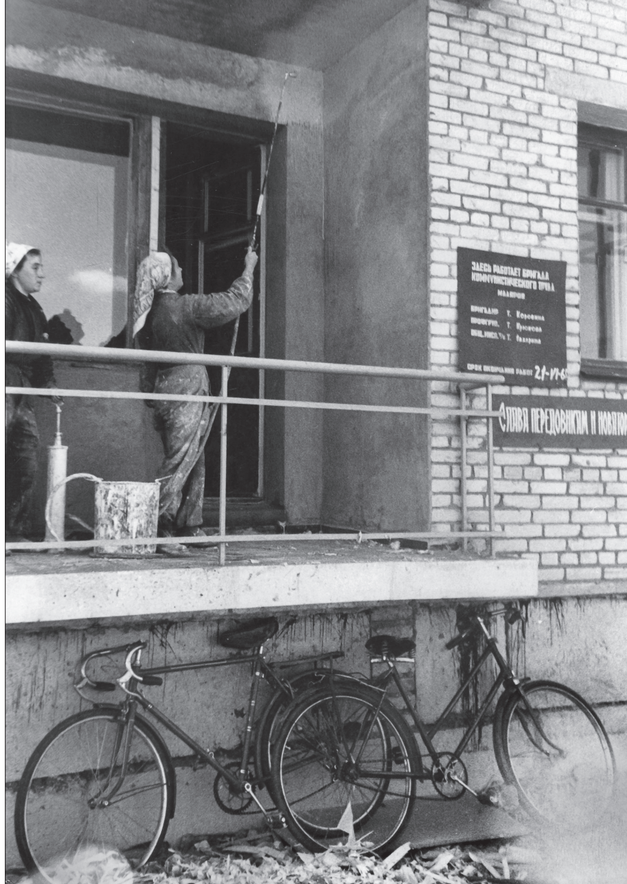
М. А. Коровина. Работа по отделке лоджии жилого дома
