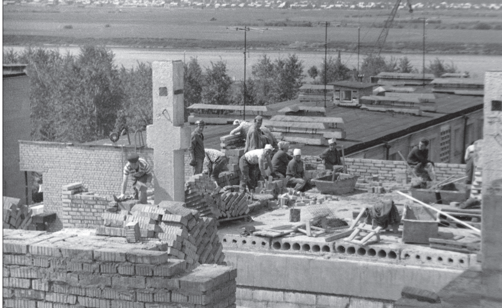
Трудовые будни. Бригада каменщиков
