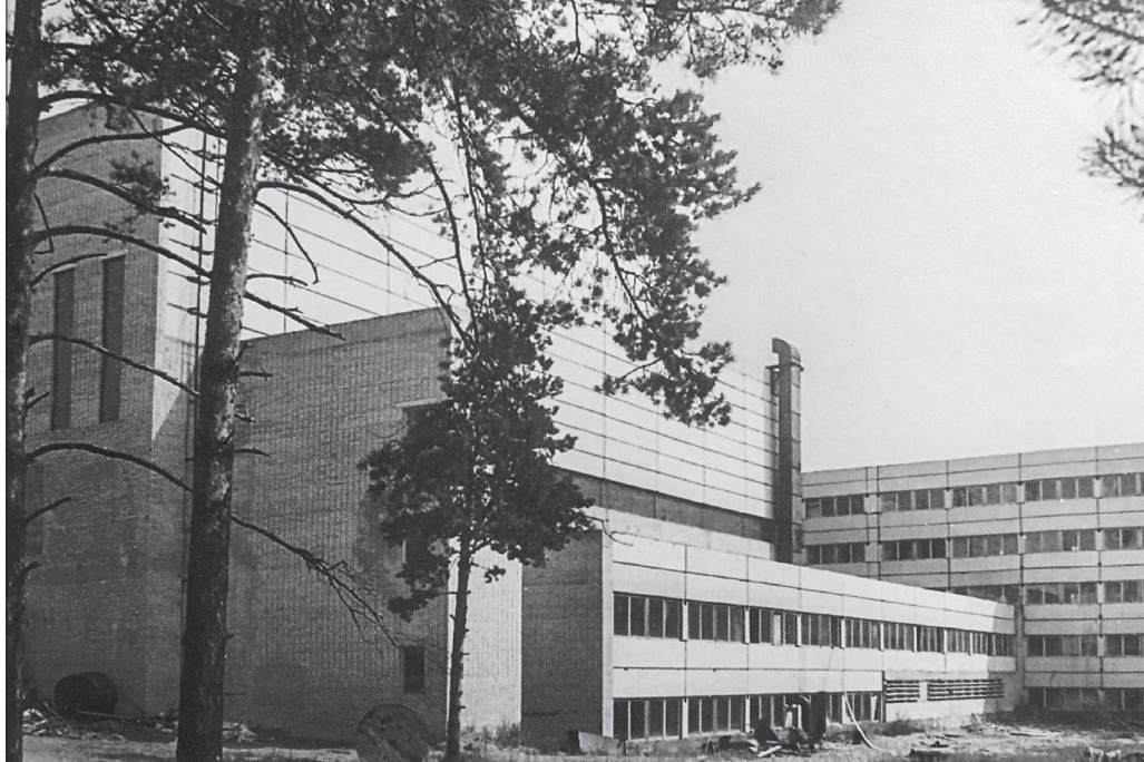
Корпус 131 Лаборатории ядерных реакций ОИАЭ, где расположена установка У-400М
