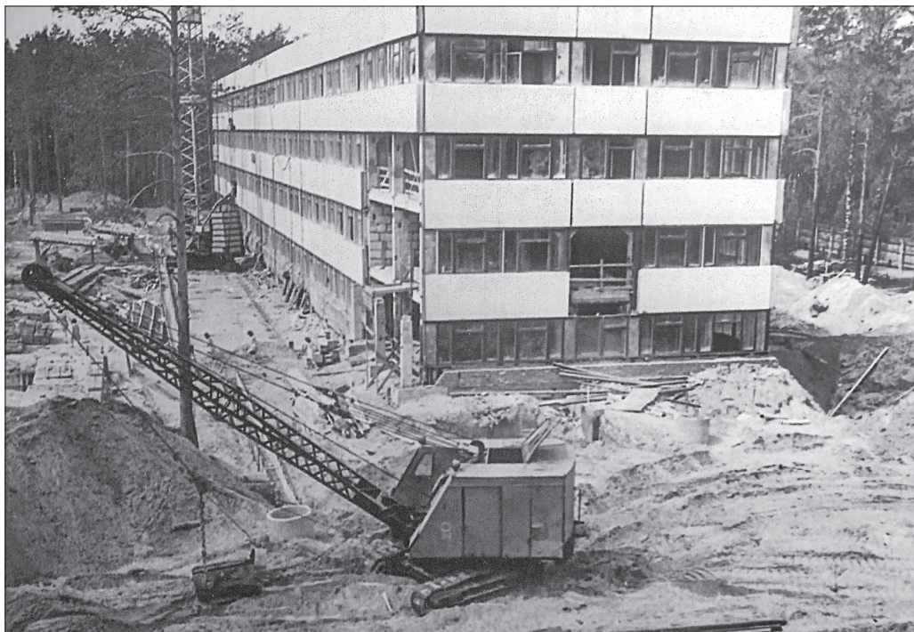
Строительство корпуса Отдела новых методов ускорения ОИАЭ
